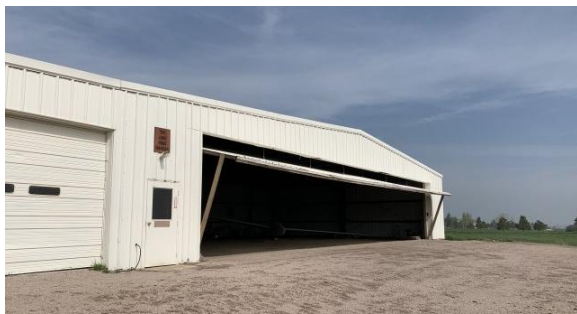
Hangar 3 door propped open
